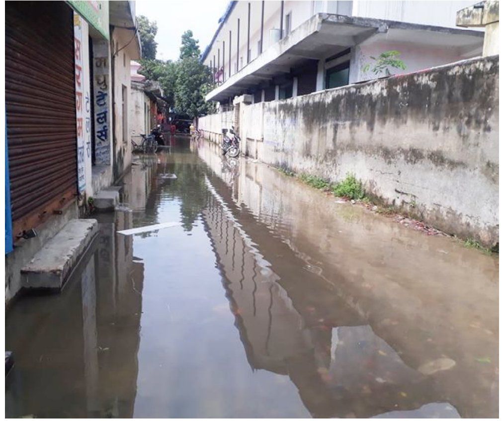
राजविराज नगरपालिकाको पश्चिम पट्टीको सडकको दुर्दसा : सामान्य वर्षामा समेत सडकमै दुई फिटसम्म पानी जम्ने गर्छ। सामान्य वर्षा हुँदा समेत वर्षाको पानी निकासको कुनै माध्यम नहुनाले सडकमै पानी जम्ने गर्दछ। वर्षादेखि यही अवस्था रहेपनि यसप्रति नगरपालिकाले कुनै चासो देखाउन सकेको छैन। यस सडक छेउमा नाला रहेपनि जहिले पनि फोहरले भरिएको हुन्छ। जसकारण वर्षाको समयमा पसलहरुमा ग्राहक समेत आउँदैनन्। वर्षाको समयमा यस्तै अवस्था राजविराजका अधिकांश सडकहरुको रहेको छ।
